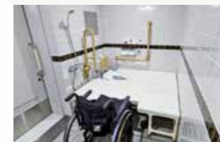
脊髄損傷者用トイレ
